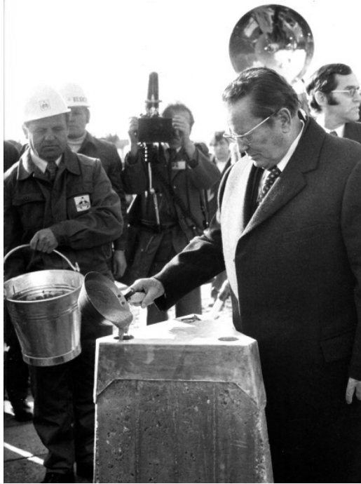
Polaganje kamena temeljca za NE Krško 1. decembar 1974. (MIJ, 1974-568-062)
