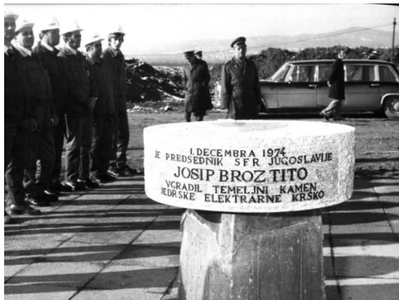
Polaganje kamena temeljca za NE Krško 1. decembar 1974 (MIJ, 1974-568-061)
