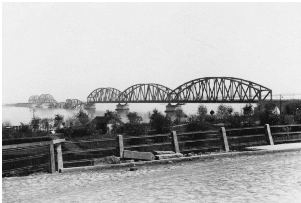
Тешко оштећени Мост краља Петра II (Колекција Душана Најијала)
