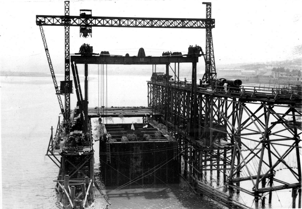
Склапање првог кесона за израду стубова будуће Панчевачког моста (Народна библиотека Србије)
